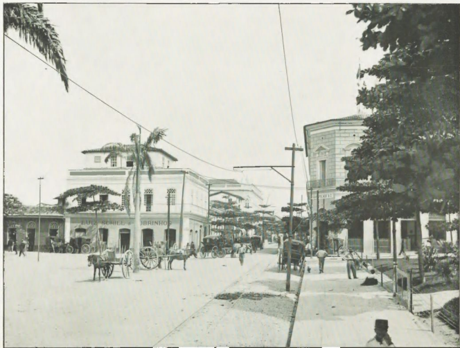
Rua da Instalação
