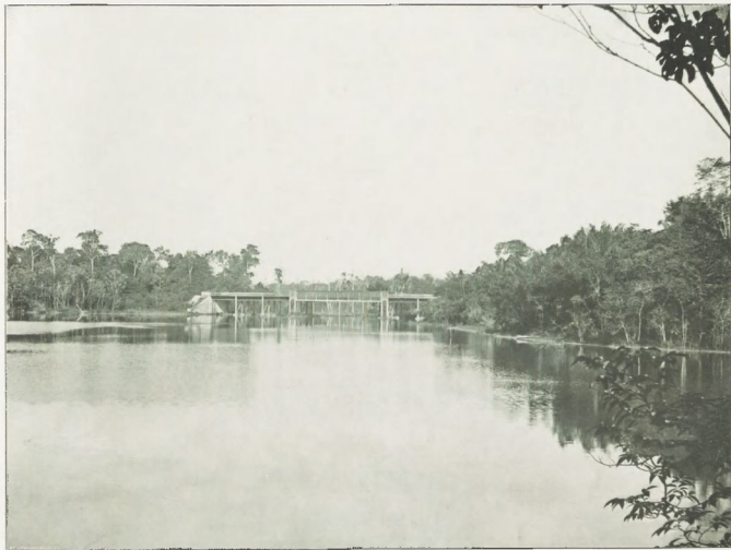
Ponte metálica na Cachoeira Grande
