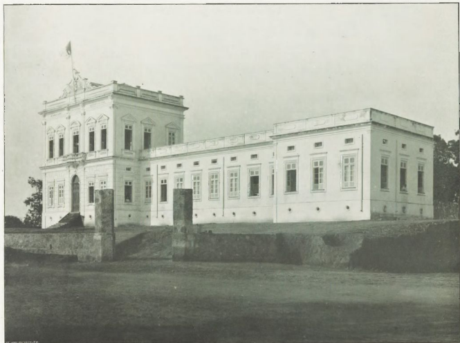
Hospital da Sociedade Portuguesa Beneficente (Por concluir)
