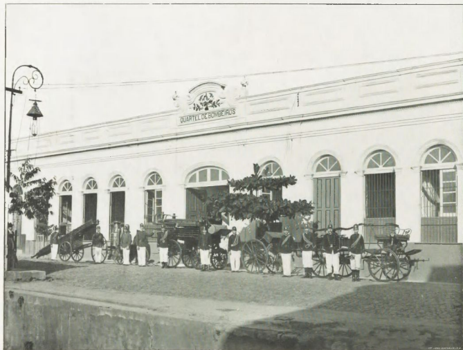
Quartel dos Bombeiros Voluntários
