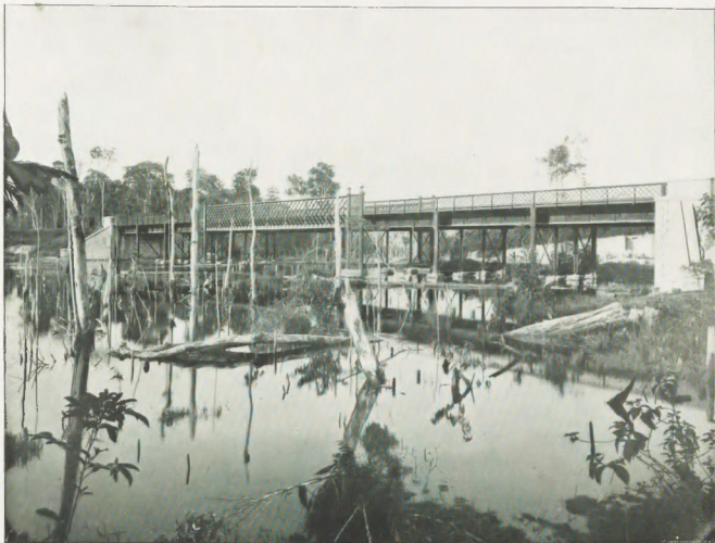
Cachoeira Grande. Ponte metálica
